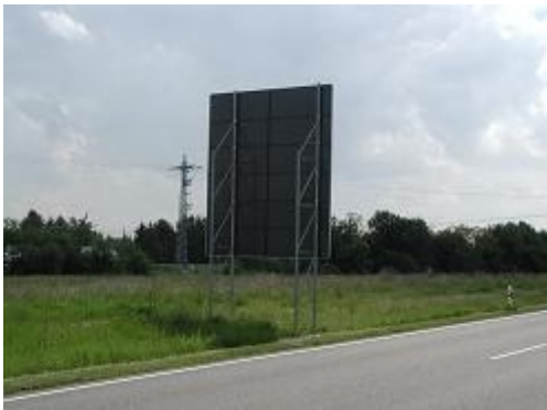
Obr. 6: Příhradové podpěry s možností přejetí (silnice II/416 Pohořelice-Židlochovice)
