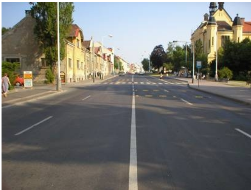
Obr: pohled na přechod s BUS zastávkou, chráněný úzkými zpomalovacími prahy
