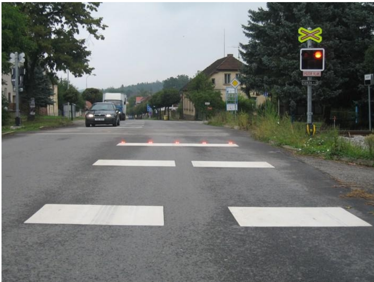
Obr. 3 - Světelná závora a optická psychologická brzda v Nové Včelnici
