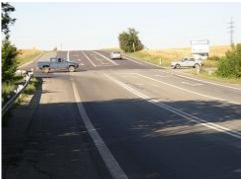
Obr. 22: Rozlehlá a nebezpečná kolizní plocha (II/430, Vyškov-Brno)
