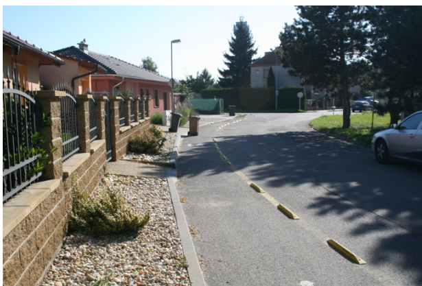
Obrázek 10. Břeclav – před osazením
