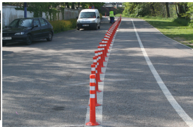
Obrázek 15. Benešov - po osazení (květen 2014)
