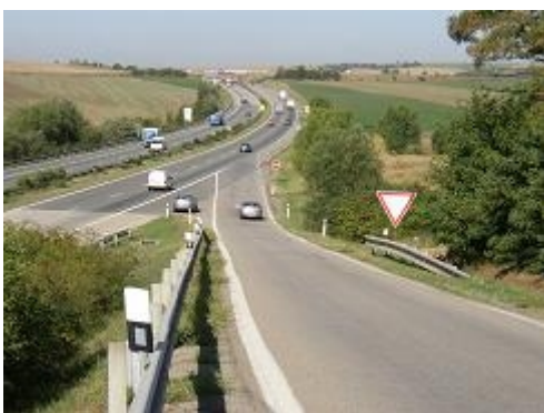
Obr. 11: Chybějící připojovací pruh (D 1, Rohlenka)
