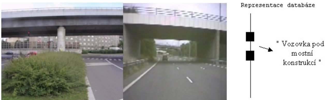
Obr. 3: Reálná situace případu Vozovka pod silniční konstrukcí, Praha 9
