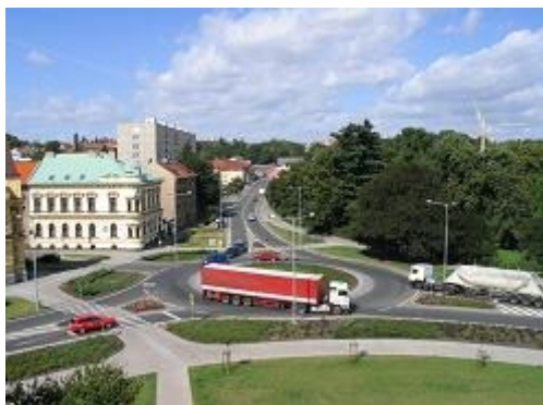
Obr. 23: Styková křižovatka nahrazená okružní (I/37, Chrudim)
