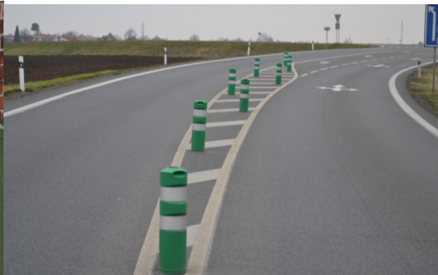
Obrázek 09. Směrové sloupky zelené kulaté - baliseta
