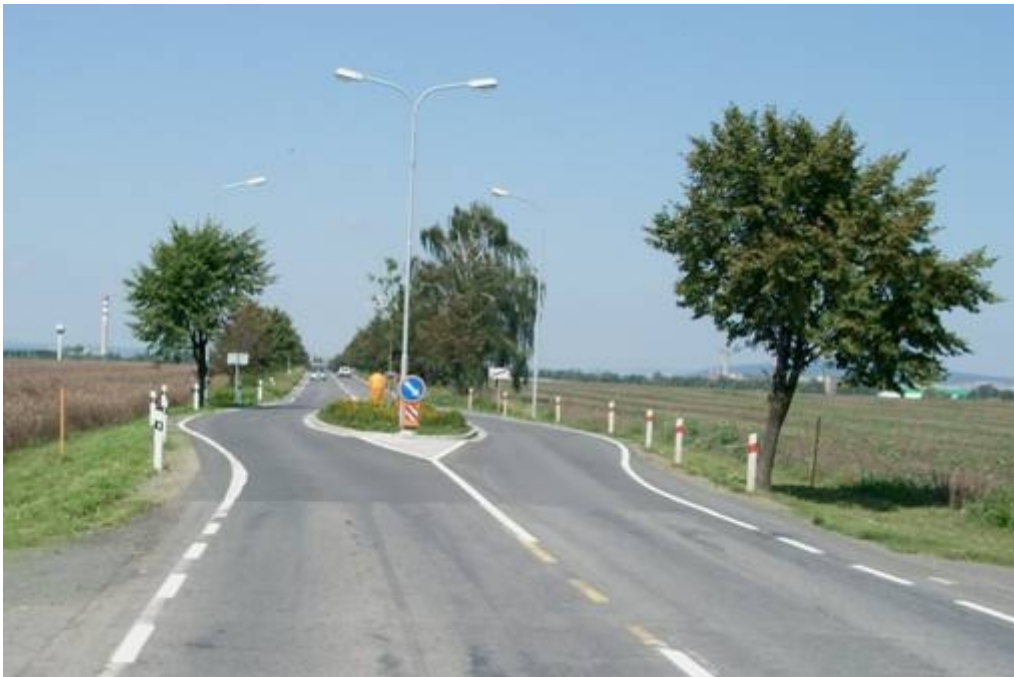
Obrázek 3: Definitivní řešení vjezdovým ostrůvkem (8/2006)
