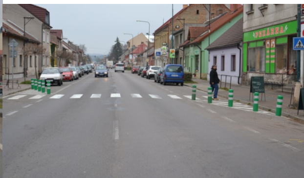
Obrázek 07. Směrové sloupky zelené kulaté - baliseta
