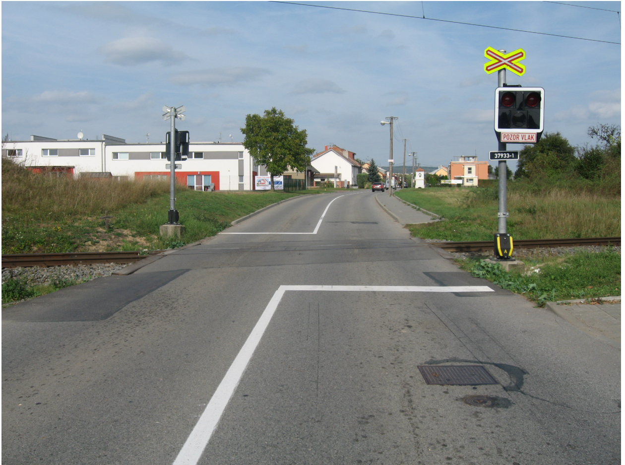
Obrázek 2: Optická psychologická brzda (modifikované provedení) před železničním přejezdem zabezpečeným výstražným křížem
